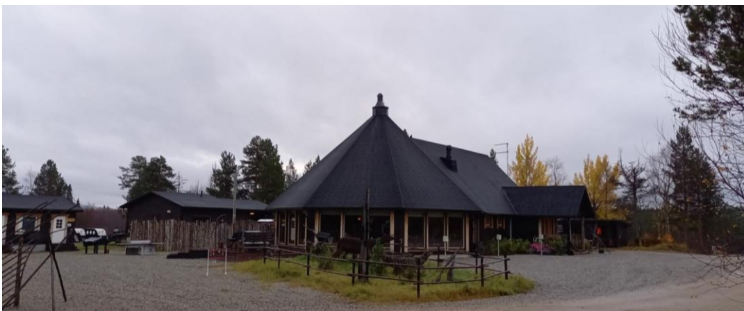
Kuva 13. Suunnittelualueen matkailutoimintojen päärakennus, jota on tarkoitus laajentaa merkittävästi. Kuva J. Lokio 2023.
