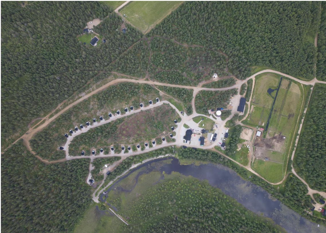
Kuva 14. Dronekuva suoraan ylhäältä alueen rakennetusta ympäristöstä. © J. Tuunanen 2023.
